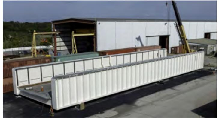
PB completó la fabricación, recubrimiento y entrega de un puente ferroviario de 120 pies de largo x 40 pies de ancho en el noreste de Estados Unidos. Este puente de 1.2 millones de libras se ensambló por completo en nuestra planta del puerto de Tampa, se desmontó y se transportó en barcaza hasta su destino.
